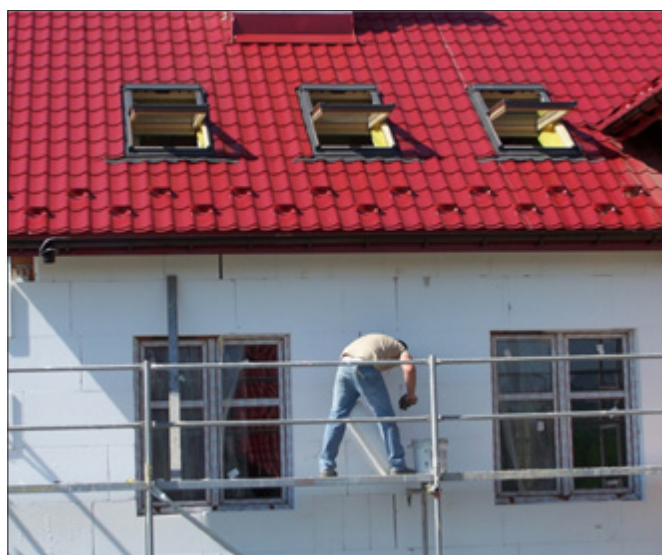
Budowa drugiego budynku na Farmie Życia (2010-2011)
